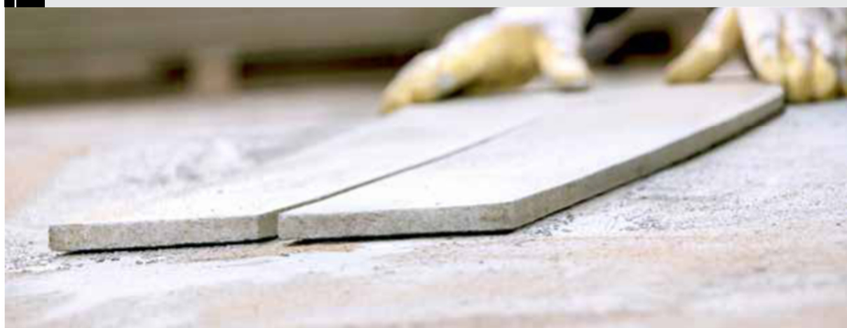
Pärast aluskonstruktsiooni rajamise etappide lõppu lõigatakse paneelid
